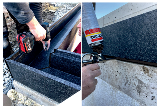
4. Steine auf Betonkronen befestigen
