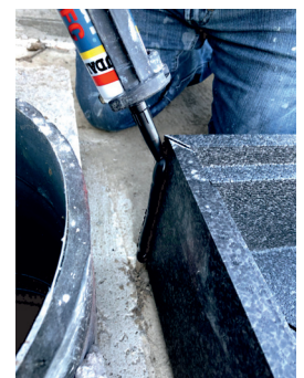
5. Gehrungen und Schrauben mit Montagekleber verschließen
