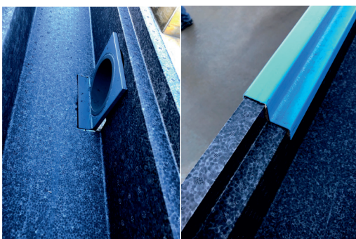
6. Abläufe und Blech montieren
