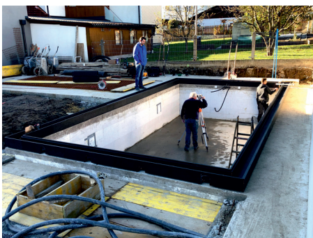
3. Mit Stellfüßen nivellieren und ausrichten
