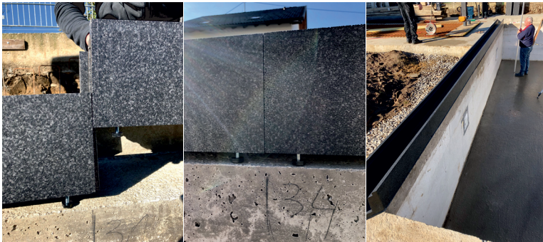
1. Stellfüße montieren und Steine zusammenstecken
