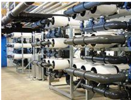
Ultrafiltration im Freibad
